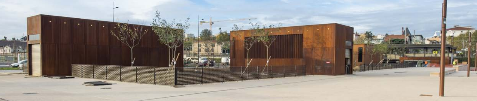
La station Gare d'Oullins, entrées Est et Nord
