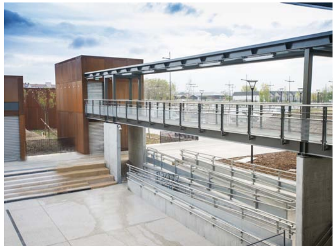
La passerelle d'accès de la station à la gare TER
