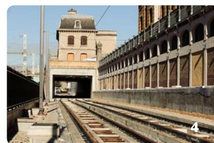
5. Le passage sous la maison du Directeur : T4 passera en partie sous les sous-sols existants de ce bâtiment art-déco datant de 1915-1920, dernier des quatre pavillons qui entouraient la Manufacture des Tabacs. Cette opération a nécessité de reprendre la quasi-totalité des fondations de la maison et de créer de nouveaux appuis en dehors du bâtiment.
