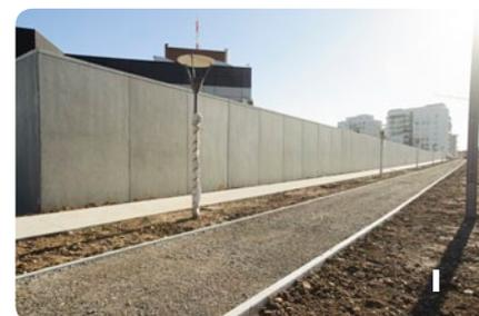
2. Le mur de soutènement le long de la rue Marius Berliet : le mur a été réalisé grâce à la technique dite des «parois moulées» ;
