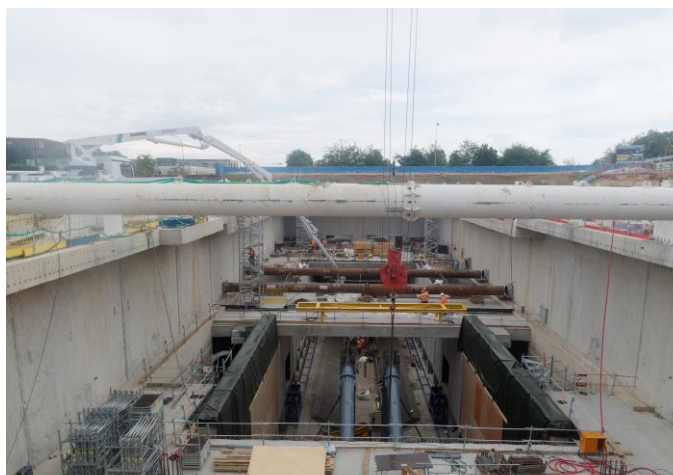
Le niveau des quais ainsi que la dalle mezzanine sont réalisés.
